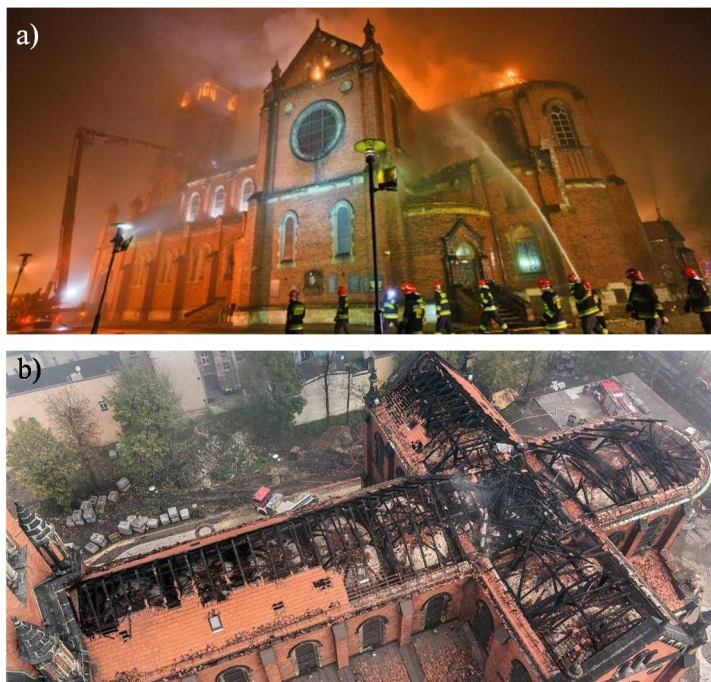
Rys. 16. Pożar (a) i uszkodzenia (b) dachu Katedry w Sosnowcu
