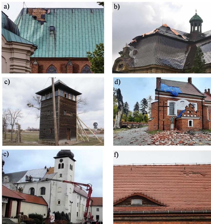
Rys. 2. Obiekty uszkodzone silnym wiatrem: a) Bazylika w Gnieźnie, 2017 r., b) Bazylika w Krzeszowie, 2017 r., c) Auschwitz II-Birkenau, 2019 r., d) kościół w Dziektarzewie, 2021 r., e) kościół w Skępem, 2021 r., f) Katedra w Świdnicy, 2022 r.
