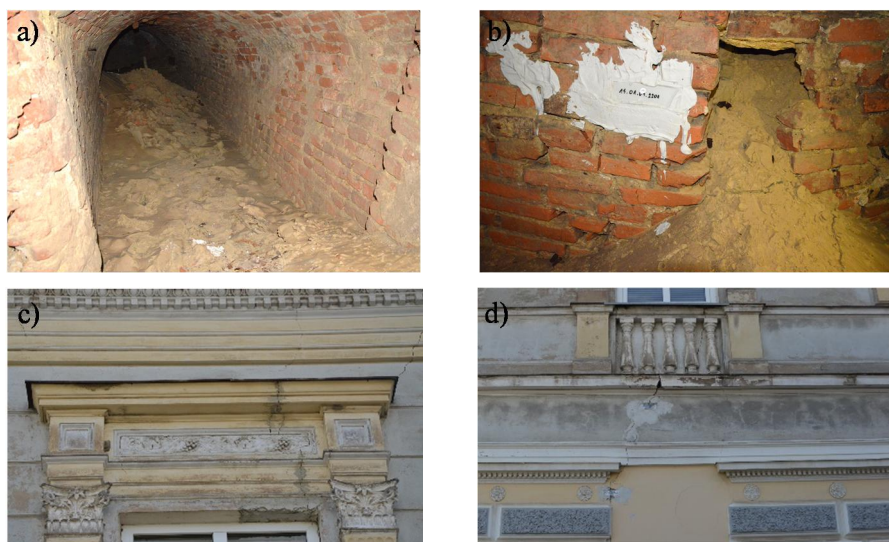
Rys. 10. Budynek w Jarosławiu: a) i b) upłynniony less, który wlał się do piwnic, c) i d) zarysowania elewacji.
