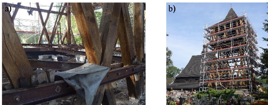
Rys. 9. Dzwonnica w Poniszowicach z XVI w.: a) widok tymczasowej konstrukcji stalowej, b) widok dzwonnicy po rektyfikacji.
