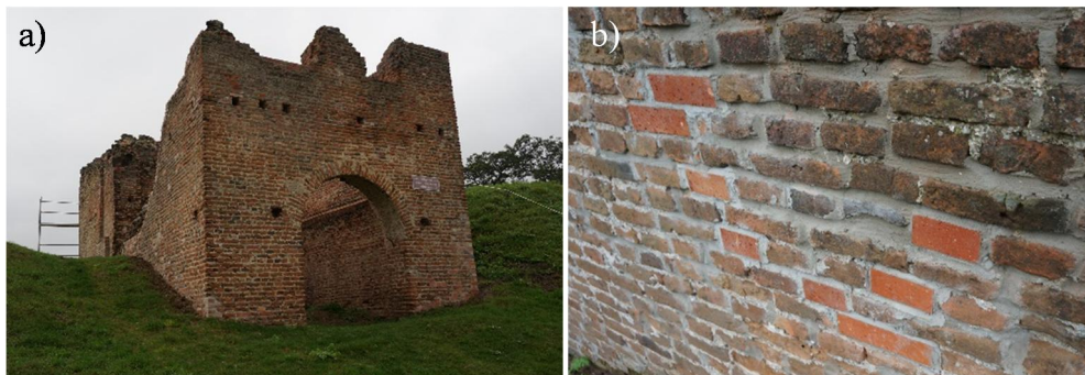
Rys. 24. Nieudana renowacja Bramy krzepickiej twierdzy w Dankowie: a) widok b) szczegół.
